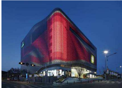
Bild 7: Einkaufszentrum Galleria Centercity in Cheonan, Südkorea: Die RGB-LED-Strahler sowie die weißen LED-Spots von Zumtobel kombinieren Licht, Farbe und Bewegung auf faszinierende Weise. Dabei ermöglicht die installierte DMX-Steuerung eine individuelle Programmierung der einzelnen LED-Spots.
