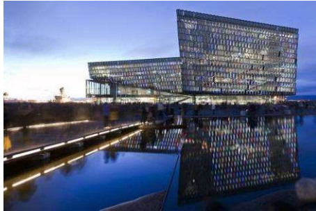
Bild 3: Das Harpa Konzertzentrum in Reykjavík: Für die Fassade entwickelte der Architekt Olafur Elíasson in Zusammenarbeit mit Zumtobel einen völlig neuen Leuchtentyp, der sich in Form und Farbe fast unsichtbar in die Prismenstruktur integriert.
